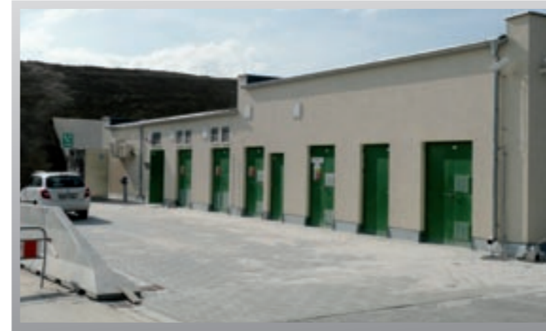
Jižní obchvat Prahy - Lahovický tunel
